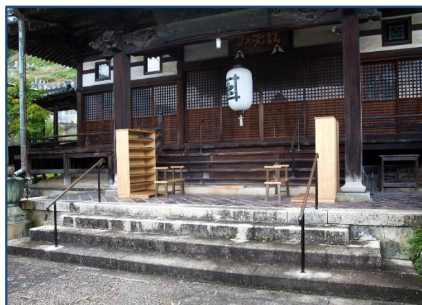
本堂石段手すり・下足箱
