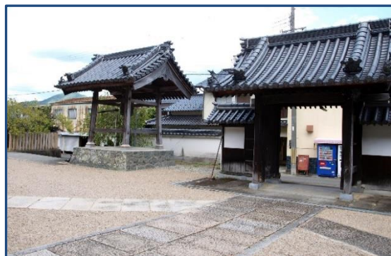
古いトイレを撤去し、すっきりとした鐘楼堂周り
