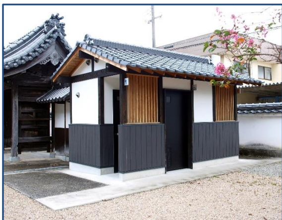
境内トイレ新設
